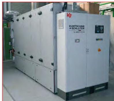
Wolf BHKW GTK 240 im Einsatz mit 365 kW thermischer Leistung und 236 kW elektrischer Dauerleistung ■
