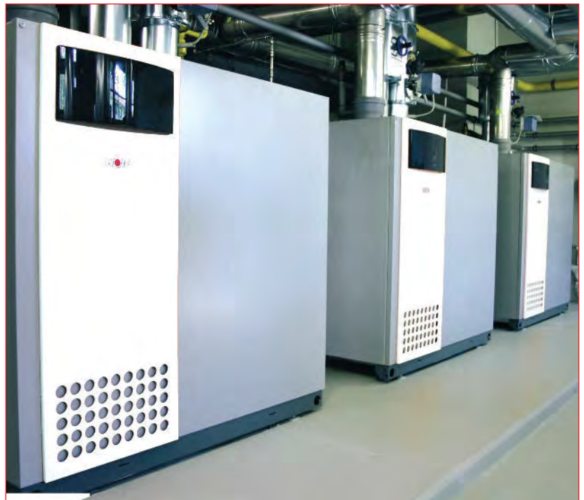
Systembeispiel: Wolf Gasbrennwert-Mittelkessel MGK in Kaskade liefern nicht nur viel Wärme sondern sparen auch sehr viel Energie gegenüber einem veraltetem Heizsystem ■
