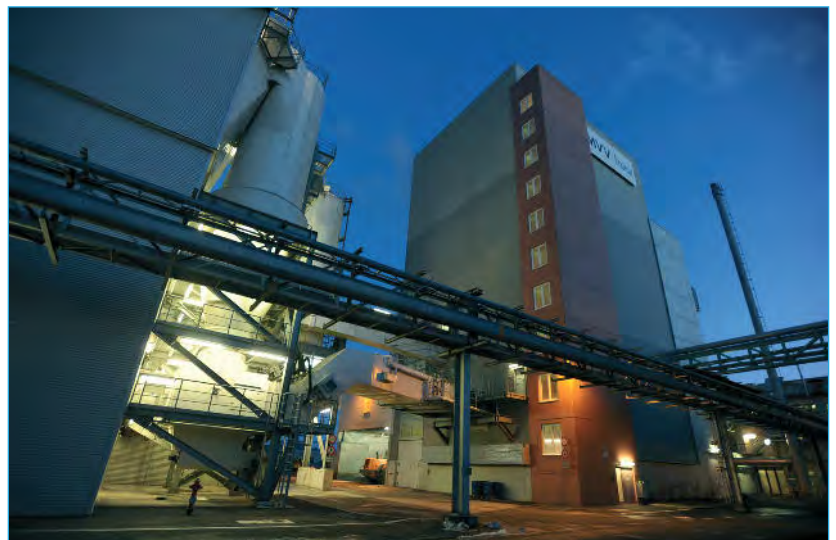
Fast 100.000 Tonnen Ersatzbrennstoffe können im Kraftwerk der MVV Enamic IGS pro Jahr zu Prozessdampf umgewandelt werden ■
