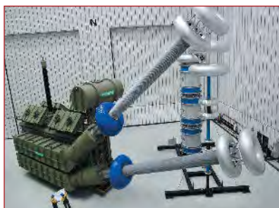
Nach erfolgreich verlaufener Endabnahme im Siemens-Transformatorwerk in Nürnberg steht der weltweit erste 800-Kilovolt-Ultrahochspannungs-Stromrichtertransformator zur Auslieferung bereit. Der Transformator kommt in der Hochspannungs-Gleichstromübertragungsanlage (HGÜ) „Yunnan-Guangdong“ in China zum Einsatz, eine der beiden derzeit leistungstärksten HGÜ-Anlagen der Welt. (Siemens-Pressbild) ■
